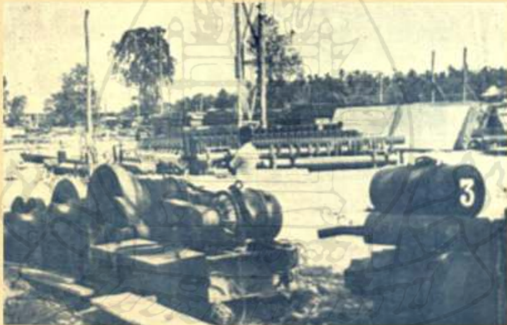
๔. เครื่องจักรต่าง ๆ เกี่ยวกับการสร้างโรงไฟฟ้า ซึ่งต้นเดือน และกำลังก่อสร้างอยู่ในขณะนี้
