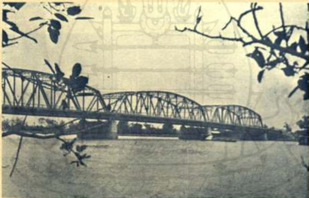
สะพานนนทบุรี ตำบลบ้านใหม่ อำเภอปากเกร็ด จังหวัดนนทบุรี
