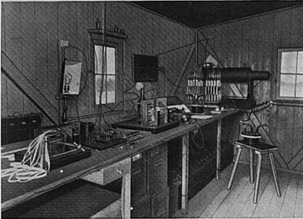
Bild 230. Inneres der auf Helgoland zum Verkehr mit Cuxhaven im Jahre 1901 errichteten Funkstation nach dem System von Professor Braun und Siemens & Halske.
