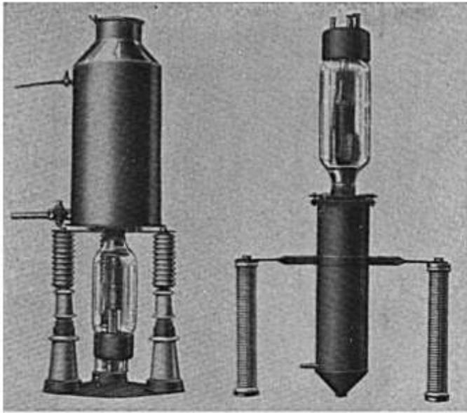
Bild 91. Aus der Entwicklung der wassergekühlten Senderöhren: Links erste Ausführung mit Siedekühlung, Verbindung von Metall und Glas mittels Platinring (1918), rechts fortgeschritteneres Stadium mit Durchflußkühlung, Glas unmittelbar mit Kupferferring verschmolzen (1920).
