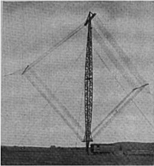
Bild 160. Aus der ersten Zeit des Gegenverkehrs mit Nordamerika: Behelfsmäßige Empfangsanlage Transradios in Geltow im Jahre 1919. 40 Meter-Holzmast mit Rahmenantenne. Das zugehörige Empfangsgerät war im danebenstehenden Möbelwagen untergebracht.
