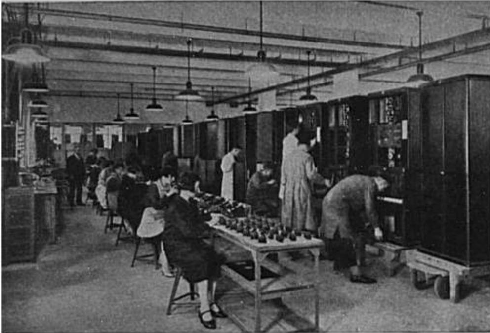
Bild 123. Aus den Funkwerkstätten bei der A.E.G. Der Serienbau von EW-Hochfrequenztelephonanlagen.
