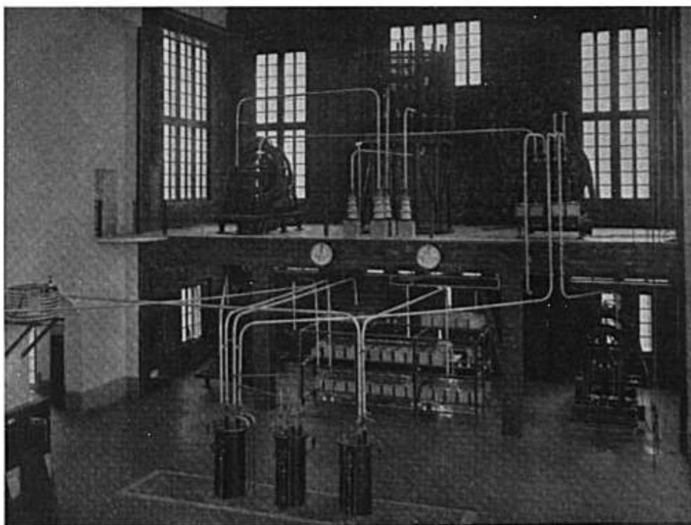
Bild 55. Großstation Rom. Im Vordergrund zwei Frequenzwandler (einer als Reserve) für Verdrei- oder Vervielfachung und Tastdrossel. Im Hintergrunde Kondensatoren, Variometer und Antennenverlängerungspule.
