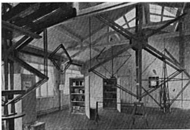
Bild 171. Transradio-Empfangsanlage Geltow 1923. Rahmen-Empfangsanlagen für die Aufnahme europäischer Gegenstationen.
