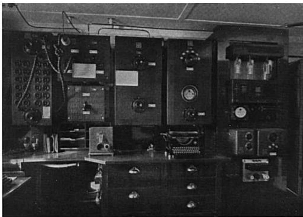
Bild 183. 1 Kilowatt-Zwischenkreisröhrensender mit Telephonierusatz auf dem Dampfer „New York“ der Hamburg-Amerika-Linie. Wellenbereich 600 bis etwa 3000 Meter
