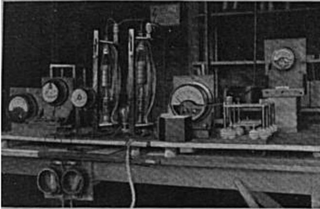
Bild 57. Ein Markstein in der Geschichte der Kurzwellentechnik: Sender pox, Nauen, mit dem der erste öffentliche Telegrammdienst nach Obersee gemacht wurde (18. Juli 1924). Wellenlänge im Anfang etwa 75 Meter, später stufenweiser Übergang zu kürzesten Wellen.
