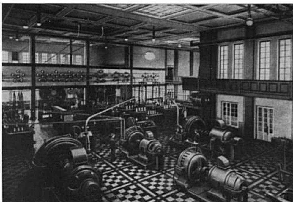
Bild 2. Blick in den Maschinensaal der Großstation Nauen im derzeitigen Zustande. Er umfaßt seit 1923 vier Hochfrequenzgeneratoren. Im Hintergrunde die Frequenzwandlerkreise, der Riegger'sche Drehzahlindikator, die Überwachungstelle und die große Antennenverlängerungspule.
