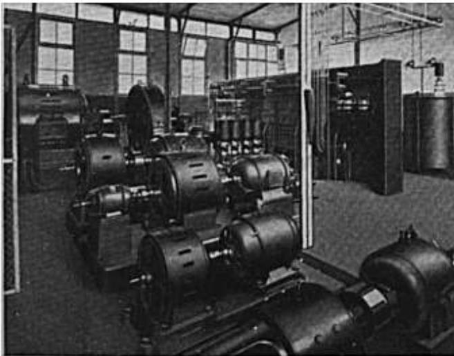
Bild 7. Versuchs- und Prüfanlage für Wasserkuhl-Senderöhren im neuen Telefunken-Laboratorium, Wernerwerk, Siemensstadt: Die Umformeraggregate, Größe bis zu 250 Kilovoltampere, die über Transformatoren und Ventile bis zu 20000 Volt Gleichspannung abgeben können.
