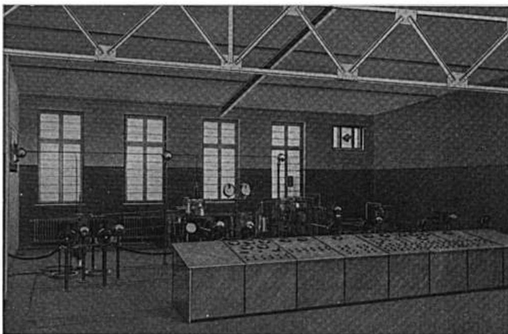
Bild 31. Hochfrequenzraum des neuen Deutschland-Rundfunksenders bei Königswusterhausen. Welle 1250 Meter, Antennen-Telephonieleistung 35 Kilowatt. In der letzten Stufe 6 Wasserkühlröhren der 20. Kilowatt-Type. Vorn das Bedienungspult mit der automatischen Druckknopfsteuerung.
