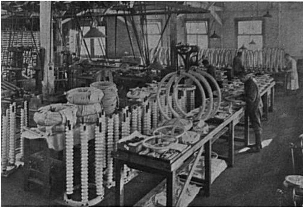
Bild 129. Aus den Funkwerkstätten der Siemens & Halske A. G., Wernerwerk. Bau von Pfeilrahmen.
