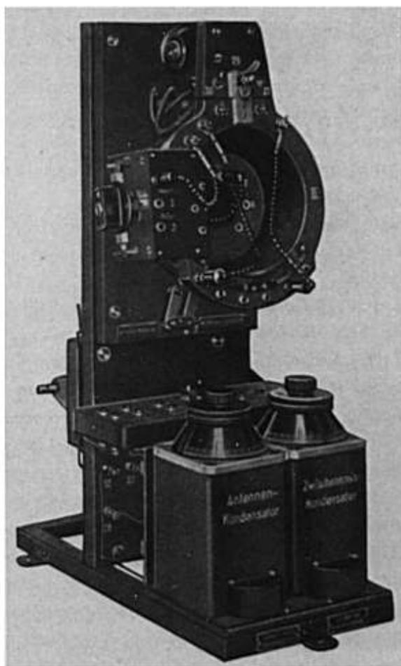
Bild 14. Detektor-Zwischenkreisempfänger E 5 für alle Wellenlängen. Bildet noch heute die Gegenanlage zum tönenden Löschfunkensender.
