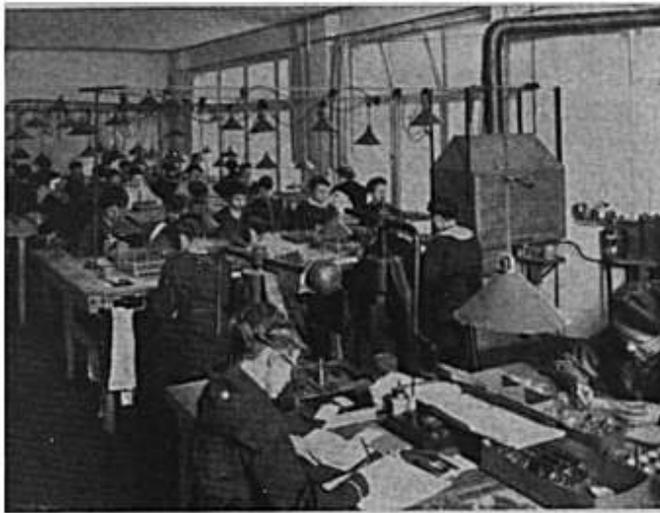
Bild 20. Aus der Zeit der Telefunken-Röhrenfabrik Friedrichstraße, 1917 bis 1920: Elektrodenherstellung und -montage für Verstärkerrohren. (Siehe H. Rukop, Die Telefunkenröhren und ihre Geschichte.)
