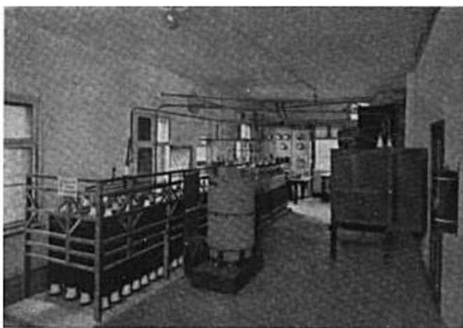
Bild 159. Vom Ausbau der Großstation Nauen: Behelfsmäßige Maschinen-senderanlage aus den Jahren 1914/1915. Frequenzwandlerraum.
