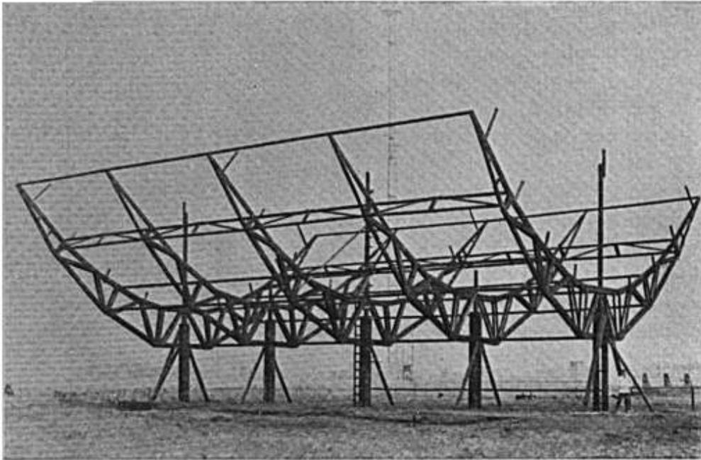
Bild 35. Spiegelstrahlwerfer mit ein- oder mehrfacher Horizontalantenne und Reflektordrahnen fur Wellen bis zu 24 Meter aufwarts, Stationsgelande Nauen. Das holzernerne Traggestell ist zur Bestimmung des gunstigsten Strahlwinkels zwischen  $30^{\circ}$  und  $150^{\circ}$  gegen die Wagerechte drehbar.
