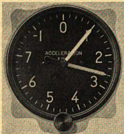
Fig. 19.—ACCELEROMETER
